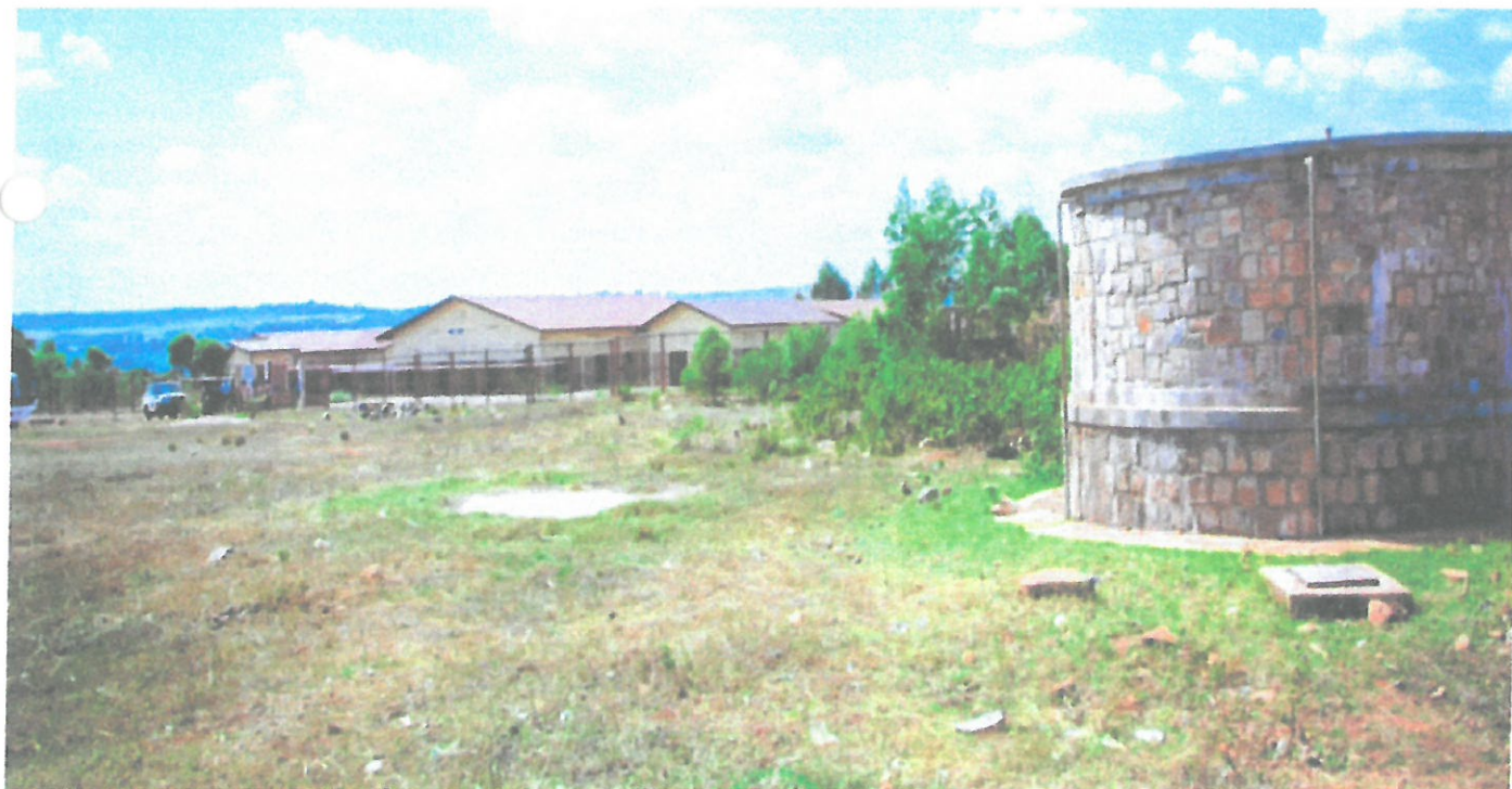
Vue partielle de l'hôpital Kigamba
